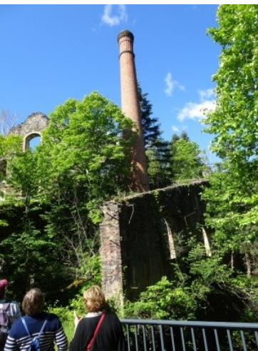
Ruines des bâtiments mais qui ont conservé la cheminée
